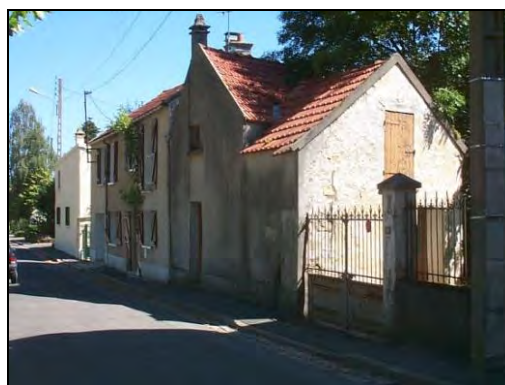
Alignement rue Jean-Marillier
