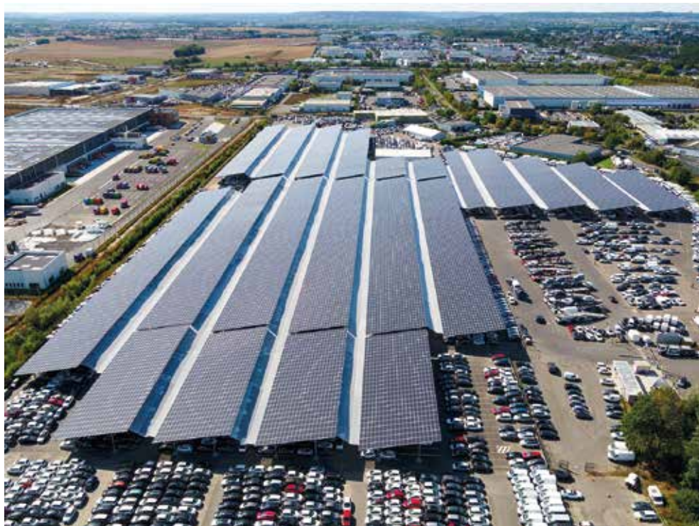
Installés sur les ombrières, les panneaux photovoltaïques produisent l'équivalent de la moitié de la consommation annuelle des Floriacumois.
