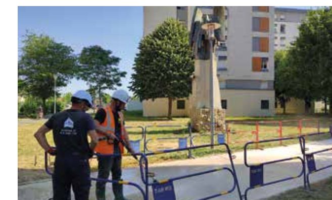
L'entreprise en action pour le cheminement des Aunettes.
